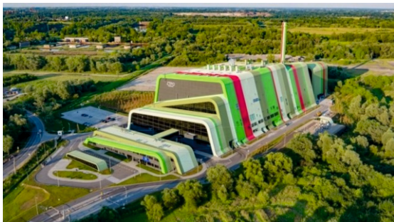
Zakład Termicznego Przekształcania Odpadów w Krakowie
